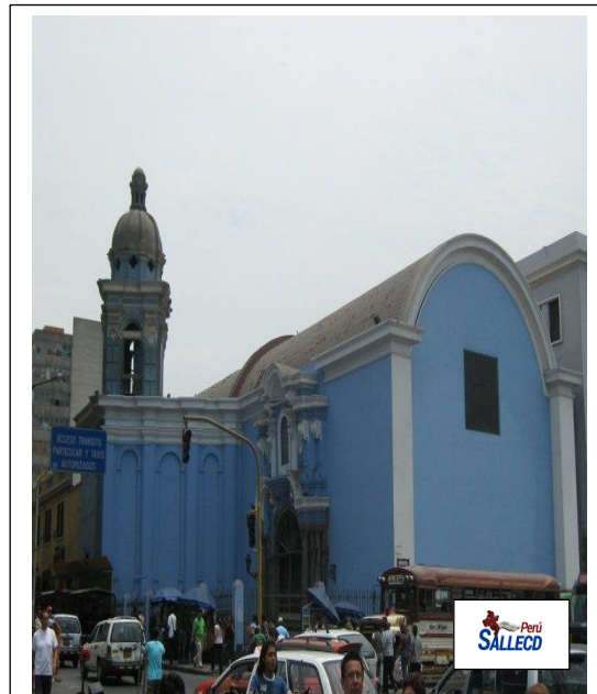
Iglesia de la Convención. Ex convento. Av. Abancay
