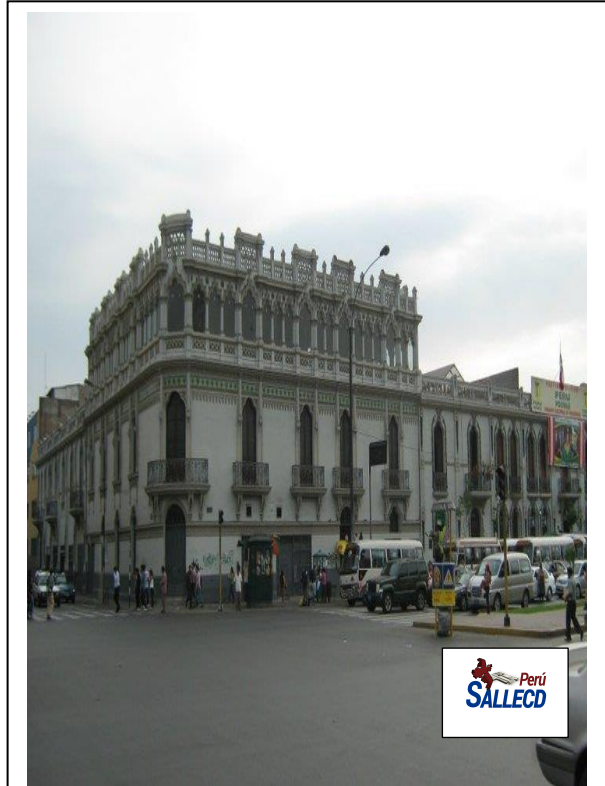
Av Paseo Colón. Casonas
