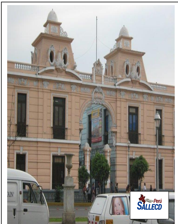
Av Paseo colón. Casonas.
